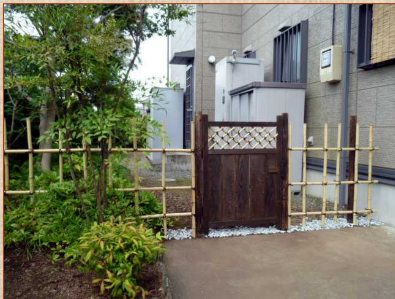
左下段の胴縁は、盛土にぶつかるので途中でカットした。
